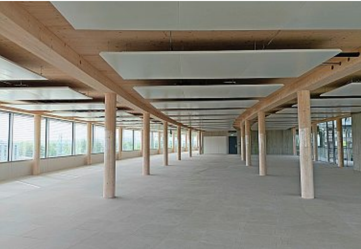
In den oberen fünf Geschossen steht eine reine Holzständer-Konstruktion. Foto: Atelier 5
