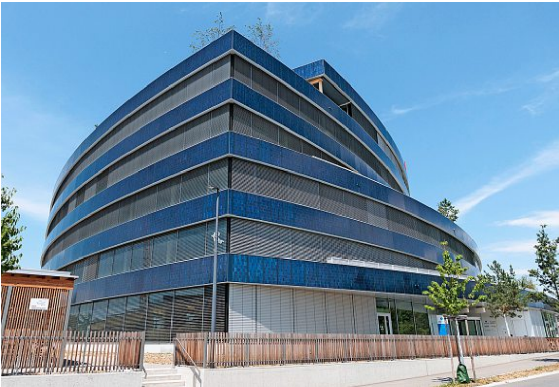
Die Form des Gebäudes Bern 131 ergab sich fast von selbst, weil das Grundstück so effizient wie möglich genutzt werden sollte. Foto: Christian Pfander
