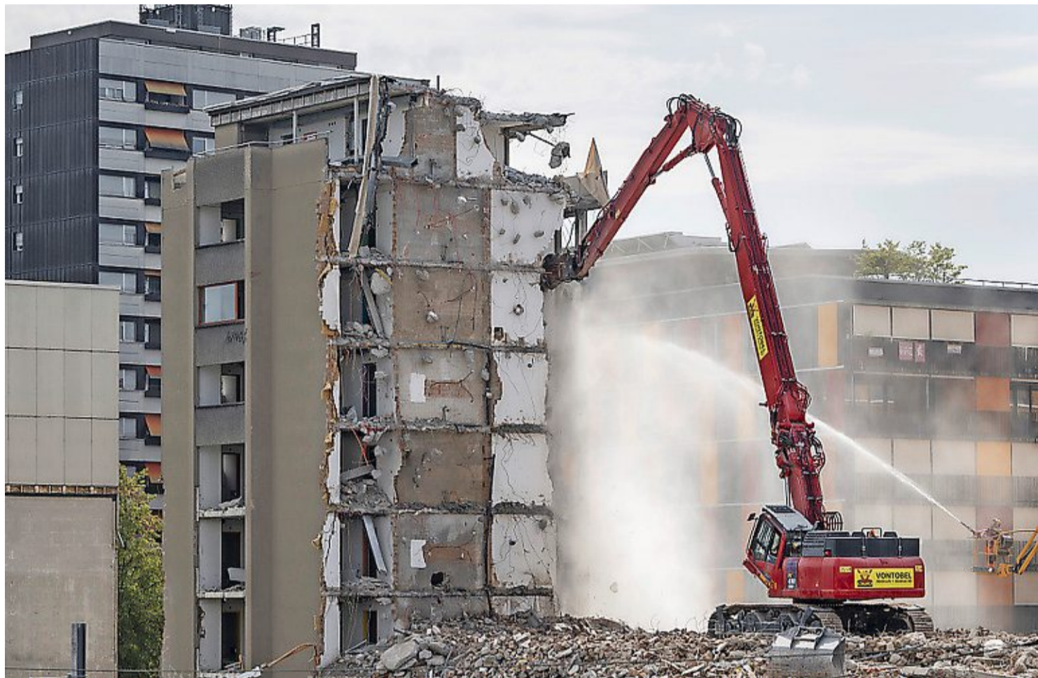
Platz für eine Gesamtüberbauung: Abbruch des Alters- und Pflegeheims im Berner Wylerring 2023. Foto: Alessandro della Valle (Keystone)
