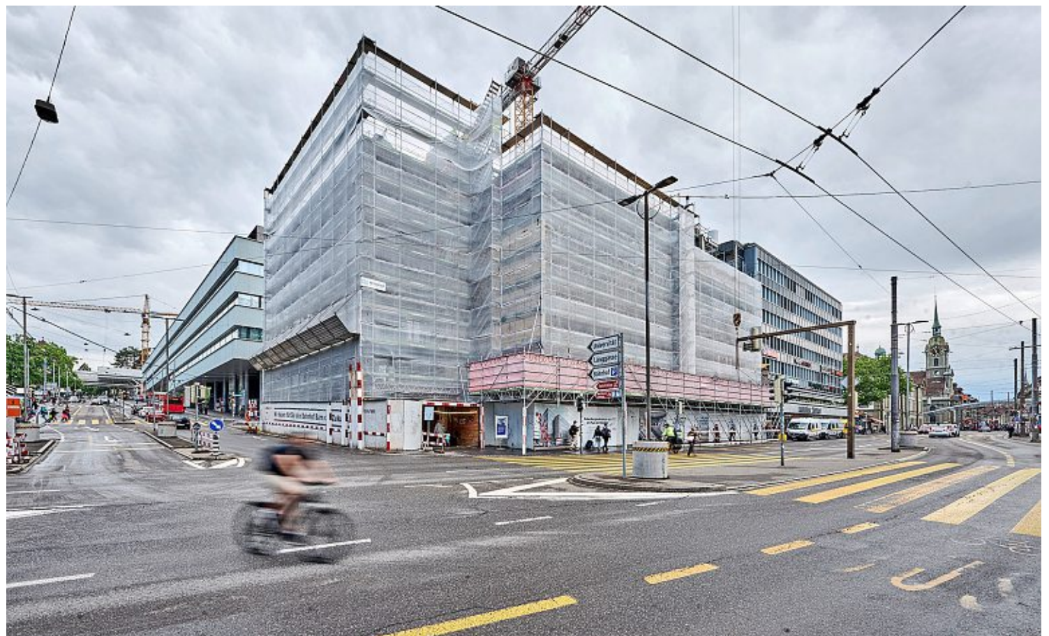
Hier befindet sich künftig der neue Eingang zum Bahnhof Bern. Foto: Adrian Moser
