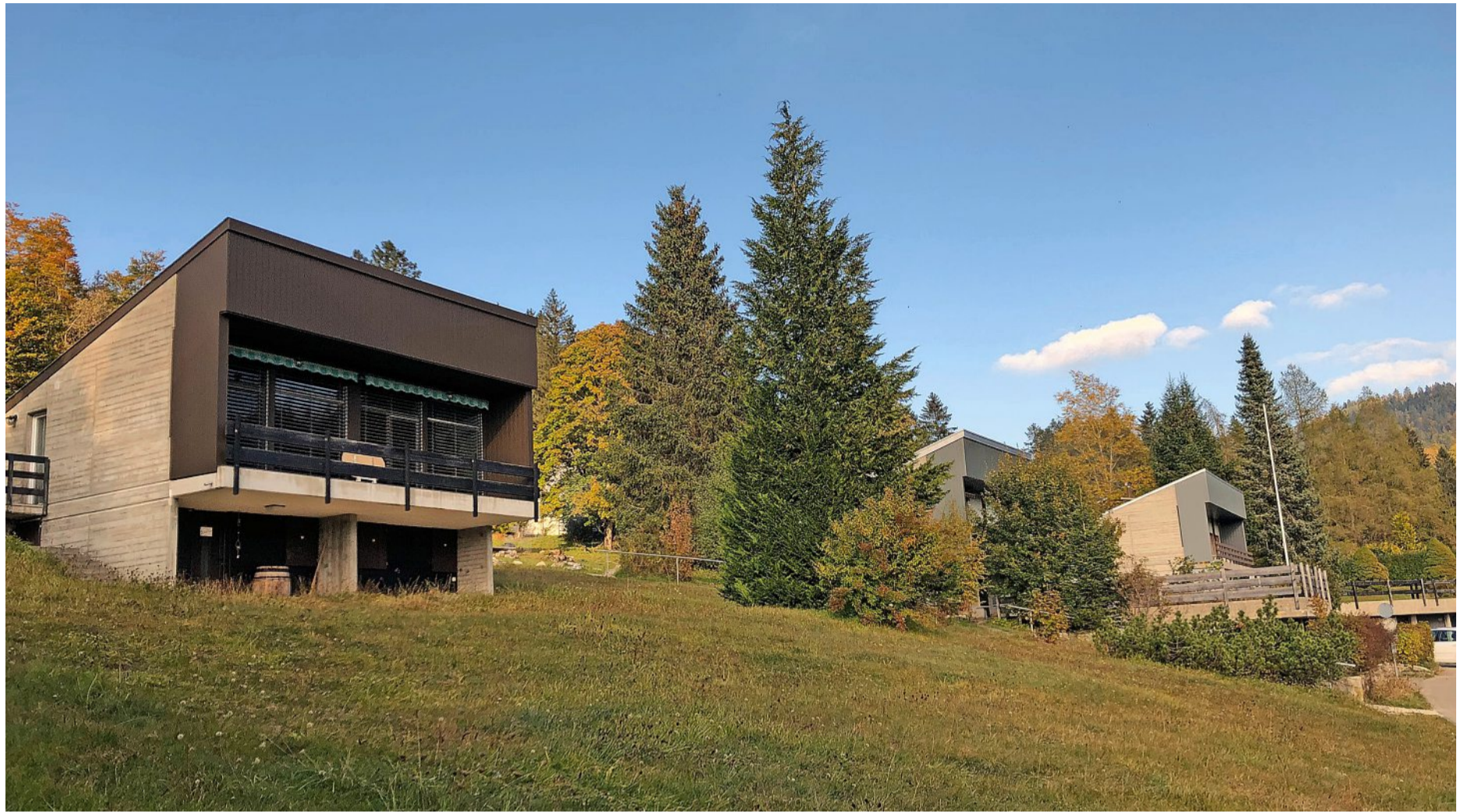
Diese kaum beachteten architektonischen Bauten in «beton brut» stehen wie Sprachrohre zwischen mächtigen Tannen an einem Südhang. Foto: Nathalie Ritter
