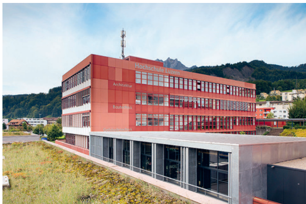
Campus des Departements Technik & Architektur in Horw.
