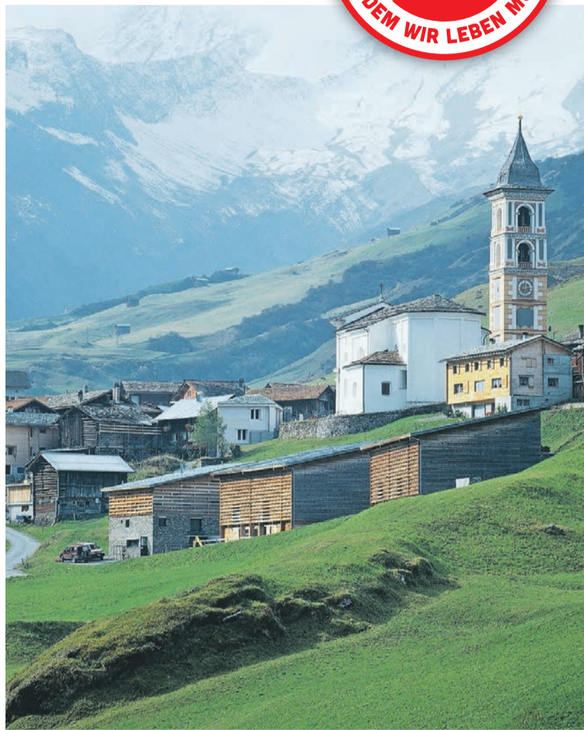
Vorbildlich. In Vrin GR gliedern sich neue Wohnhäuser und Landwirtschaftsbauten vorbildlich in das historische Ortsbild ein.
