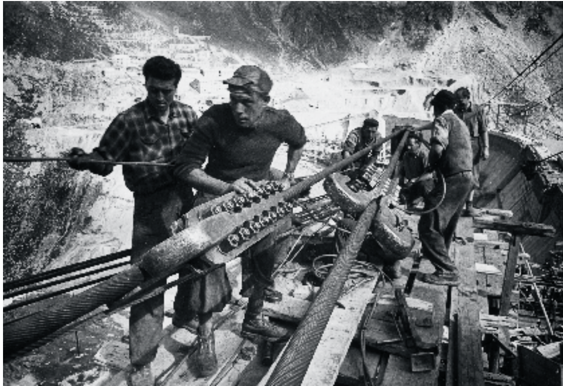
Arbeiter beim Staudambau Oberaar, ca. 1952. (Foto: Jakob Tuggener, Jakob Tuggener- Stiftung, Uster)
