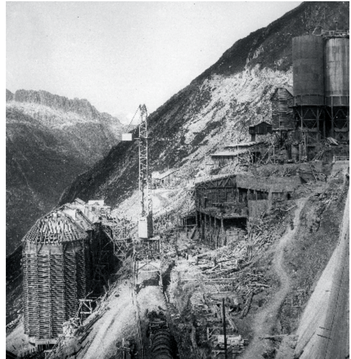
Die Staumauer ist fertig gebaut, nun beginnen die Abbrucharbeiten der Baustelleninstallationen, August 1953. (Foto: Heinz Bysäth, Archiv KWO)
