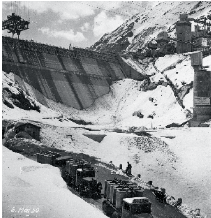
Zementtransport, im Hintergrund die «Johnson-Türme» zur Betonaufbereitung und die fast fertige Räterichsboden-Staumauer, im Mai 1950. (Foto: Heinz Bysäth, Archiv KWO)
