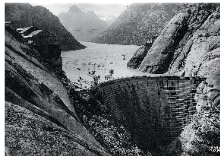
Baustelle Spitallamm Sperre, links am Nollen die Zementsilos und das Betonwerk, Photo-Salathé, 1930. (Foto: ETH Bibliothek Zürich, Bildarchiv)
