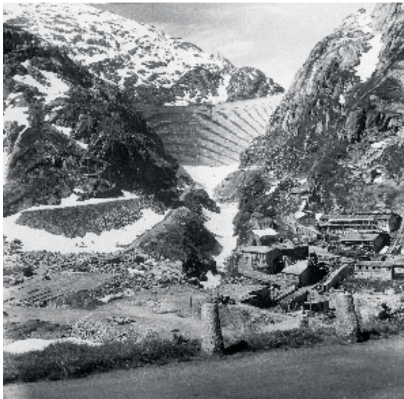
Baustelle im «Sommerloch» unterhalb der Staumauer Spitallamm, im Juni 1952 (Foto: Heinz Bysäth, Archiv KWO)
