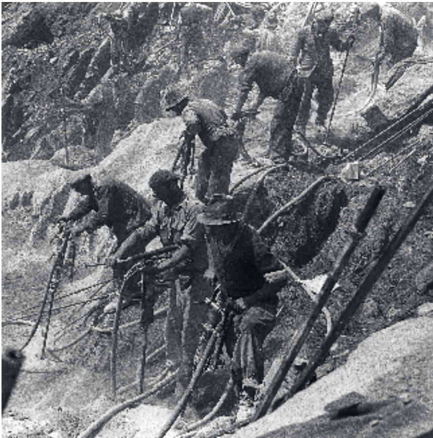
Mineure bohren Sprenglöcher für den Bau der Staumauer Oberaar, 1951. (Foto: Hans Tschirren, Staatsarchiv des Kantons Bern, FN Tschirren 15.41)
