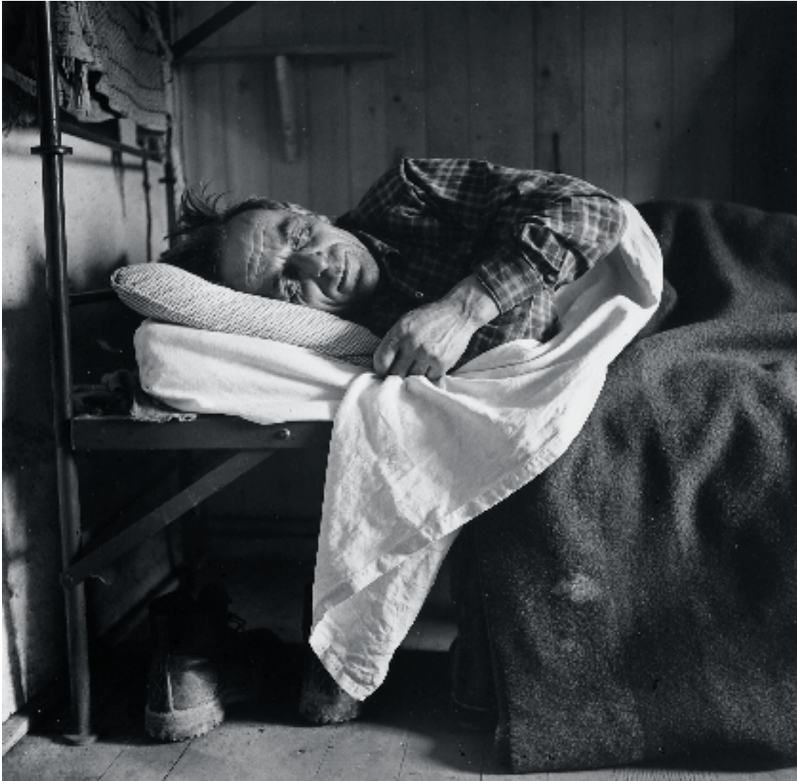
Arbeiter in der Baracke der Baustelle Oberaar, 1952. (Foto: Anita Niesz, Fotostiftung Schweiz, 2017.40.007)
