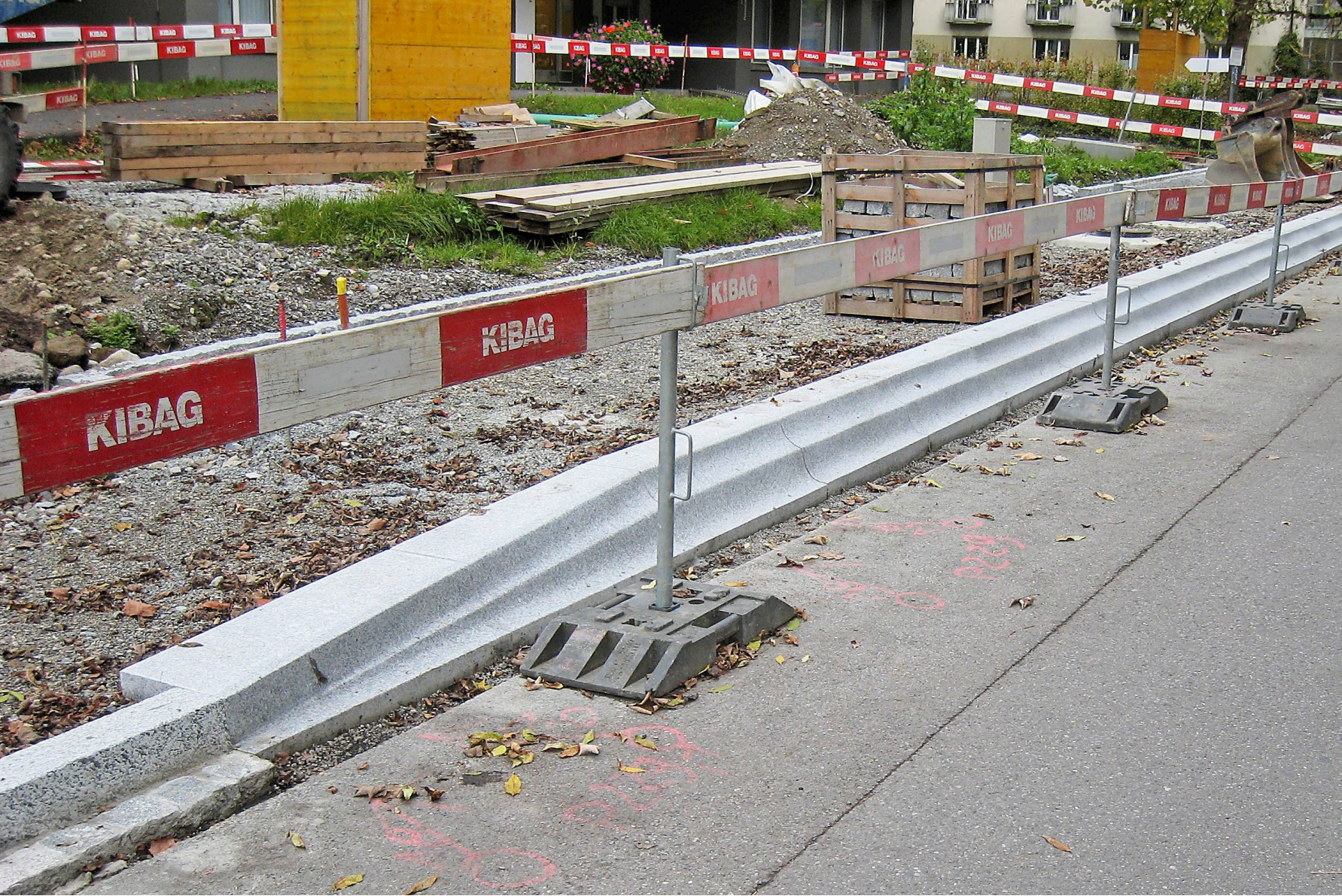
Bushaltestelle an der neu gestalteten Freiburgstrasse: Wie viel Aufmerksamkeit schenken wir doch der Frage, wie hoch eine Bordsteinkante sein darf! Foto: zvg
