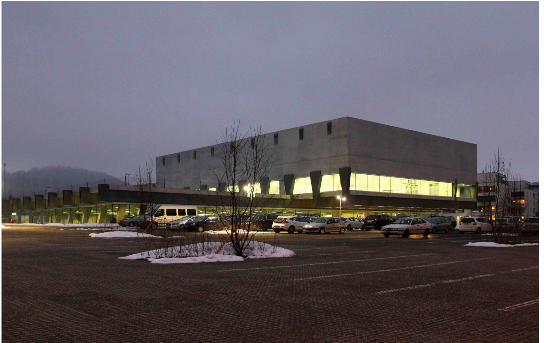
Umlaufende Fensterbänder verleihen dem massiven Betonkoloss eine erstaunliche Leichtigkeit. Foto: zvg
