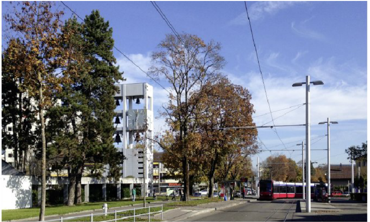
Der Bau des Trams nach Brünnen wurde zum Anlass genommen, einen neuen Strassenraum zu gestalten, wo das Miteinander gelebt werden kann. Foto: Christoph Schläppi
