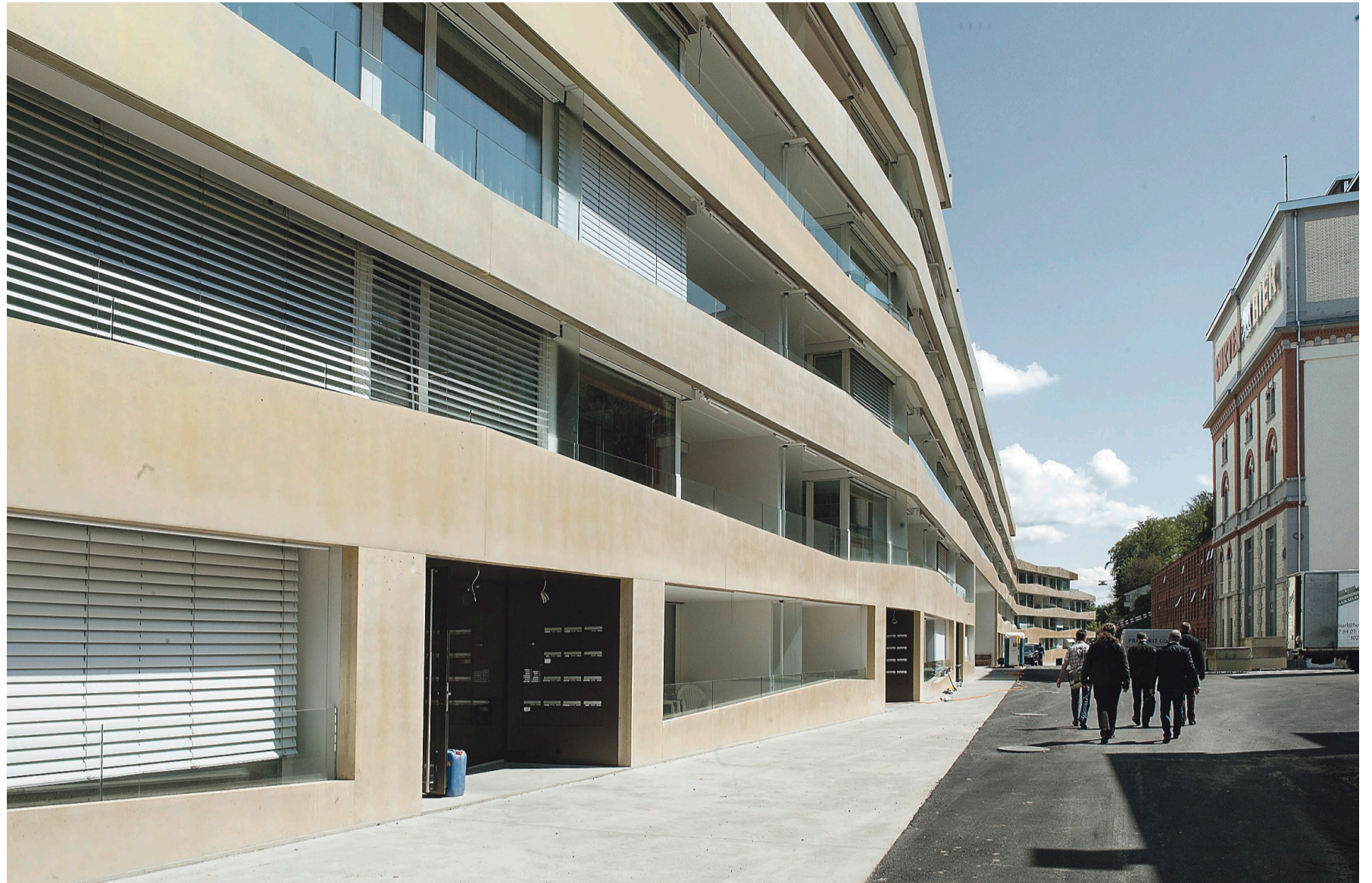
Am Fusse des Berner Hausbergs tut sich was: Das alte Sudhaus (rechts im Vordergrund) mit den beiden Neubauten. Foto: Valerie Chételat
