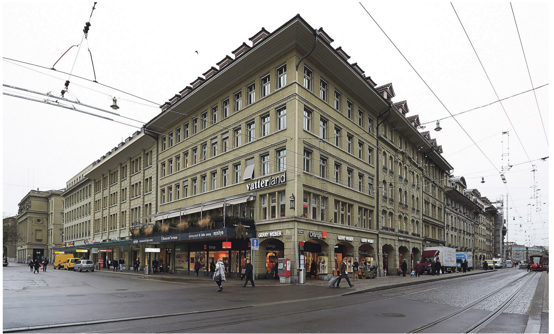
Das Gebäude wirkt, als sei es immer schon hier gestanden - es ist aber mindestens das dritte an diesem Standort: Eckhaus Spitalgasse/Bärenplatz, erbaut 1929. Foto: Thomas Reufer
