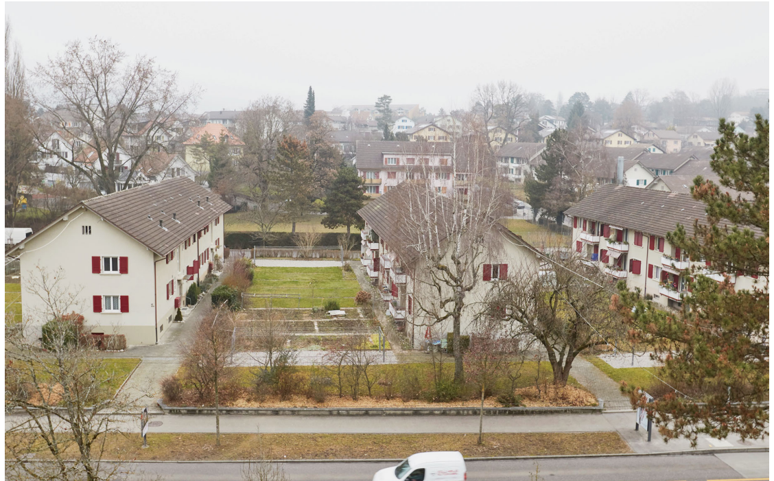
Quartier mit Potential: Typische Wohnhäuser an der Orpundstrasse. Daniel Mueller
