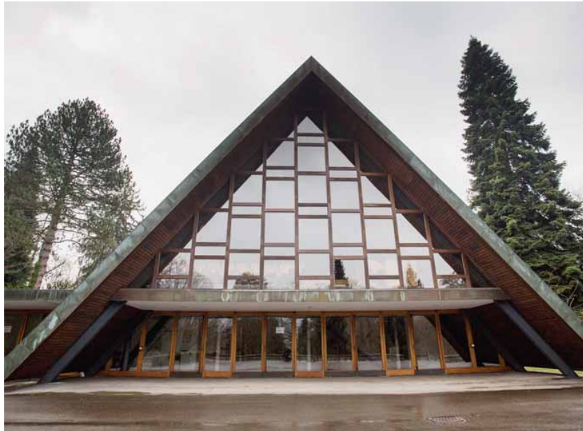
Ein starkes Dach und eine lichtdurchlässige Fassade: Die minimalistische Kapelle 2 mit Zelt Dach im südöstlichen Teil des Friedhofs Madretsch. Patrick Weyeneth
