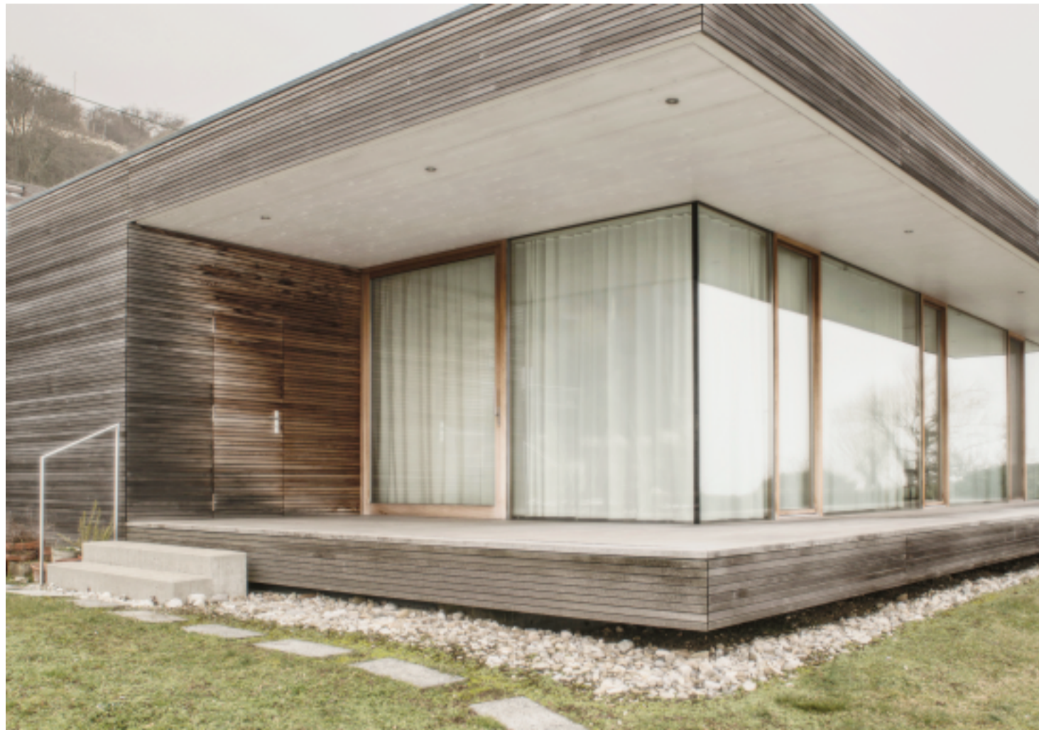
Auf den See ausgerichtet: Der loftartige Wohnbereich des Hauses ist nur durch einen Glasschirm vom Aussenraum geschieden.
