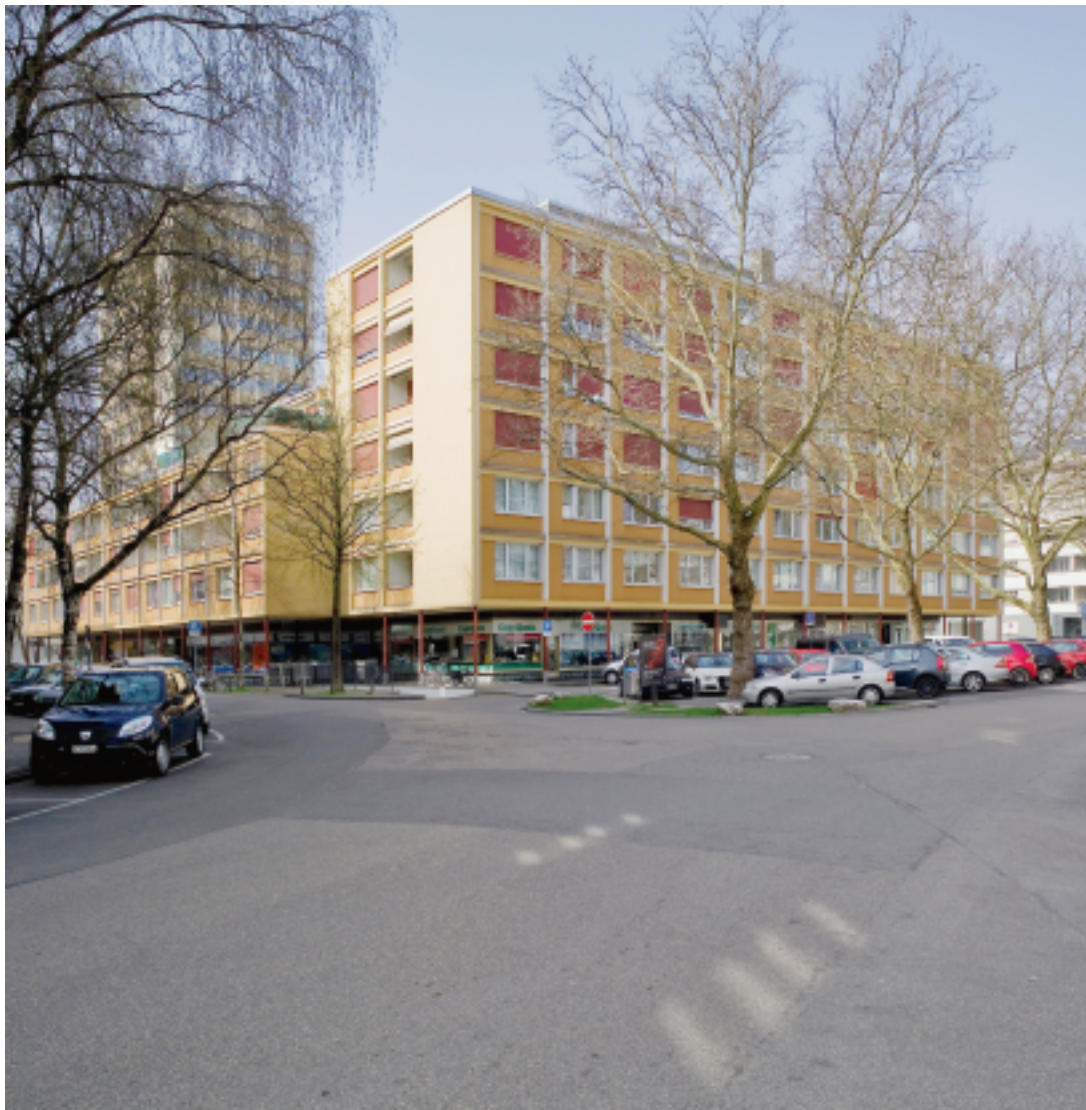
1998 wurde der Gebäudekomplex als «störend» bezeichnet. Das ist aus heutiger Sicht zu undifferenziert. Obwohl er einen Bruch darstellt, repräsentiert er einen interessanten Aspekt der Bieler Planungsgeschichte. Christian Stucki/zvg
