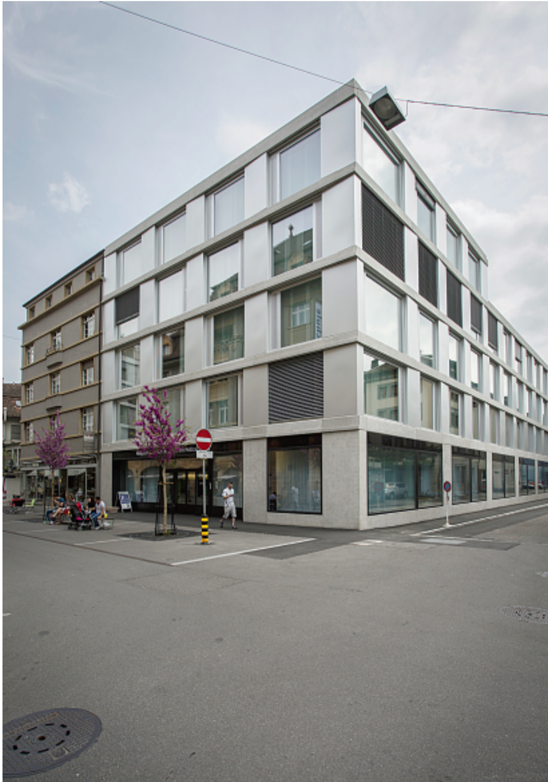
Von aussen ist es ein glitzrig-glänzender Block. Man muss genau hinsehen, um zu merken, wie die Sturzhöhen des Altbaus im Neubau weitergeführt werden.
