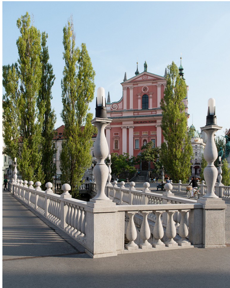
Tromostovje (les Trois-Ponts) 1929-1931
