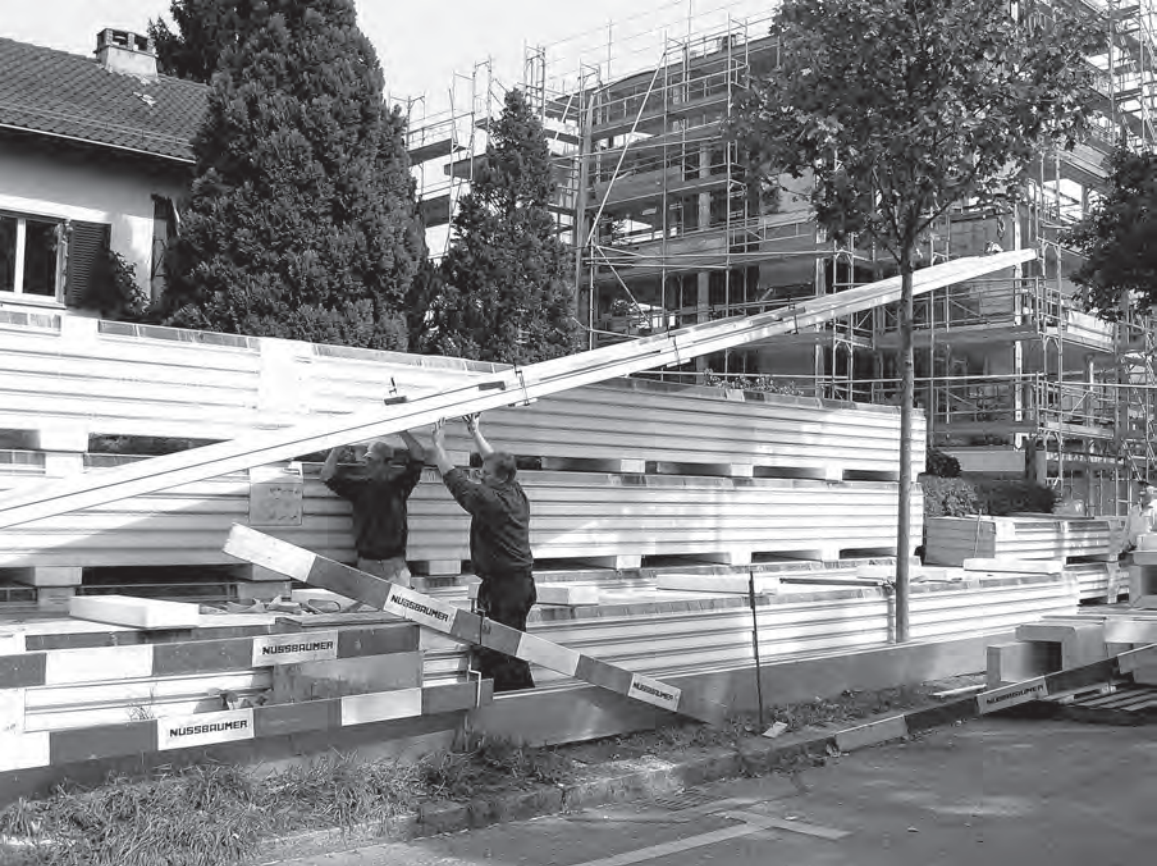
Familienwohnhaus Regensbergstrasse, Zürich/ GRASER ARCHITEKTEN AG, Zürich/ Direktauftrag, freundlich vermittelt von Anna Wimmer, Bern
